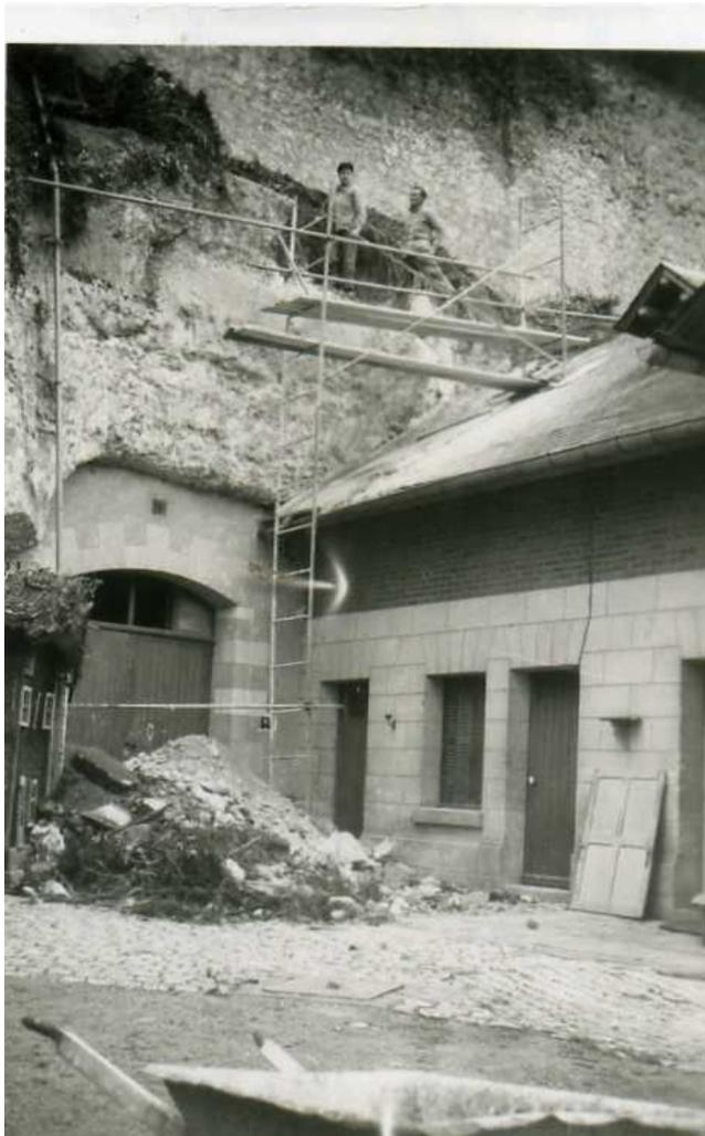
Figure 131. Il fallut entreprendre un renforcement du coteau après l'effondrement de janvier 1961 (photo famille Brosseau).
