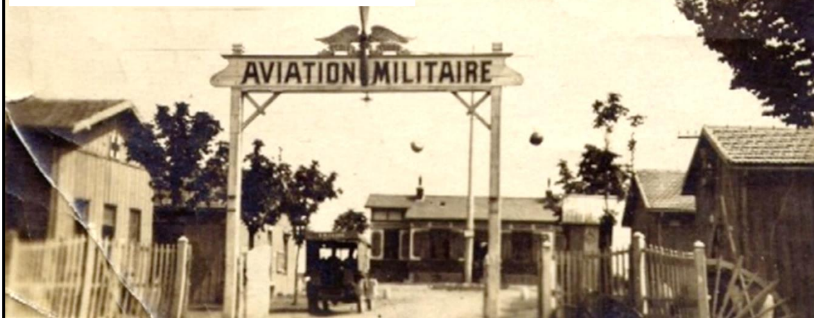
Figure 240. Portique d'entrée du Camp de Parçay
