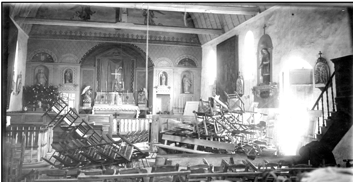
Figure 123. L'église en 1906 ; la configuration interne est identique à celle du XVe siècle, après les réaménagements internes. On y voit parfaitement la fausse paroi Est avec ses peintures, elle crée une « pseudo » abside inscrite dans celle de pierre ; elle est dans l'axe de la nef. La porte de la sacristie (derrière l'autel) est ouverte sur la gauche. L'ancien chœur, réservé aux moines de Marmoutier est encore en place, ainsi que la chaire ; les deux grands tableaux sont accrochés de part et autre de la nef. Noter la similitude entre les deux statues d'anges de part et autre de l'autel et la peinture du fronton du retable.
