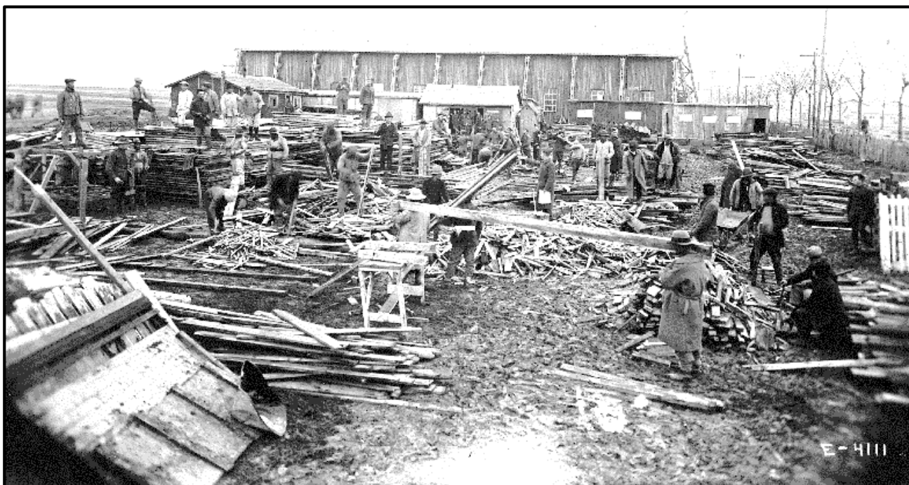
Figure 296. Mise en chantier des nouveaux baraquements ; un examen attentif de cette photo montre la présence d'ouvriers chinois (source US)
