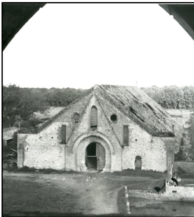
Figure 69. Les dégâts sur la grange sont d'importance ; les tuiles ont été soufflées par l'explosion, la toiture crevée par endroit. Le fleuron central, au sommet de la façade n'est plus là, il sera, ultérieurement, remis en place.
