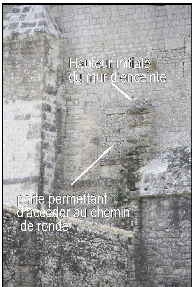
Figure 62. Côté Ouest du portail : l'arrachement des pierres montre la hauteur initiale de la muraille d'enceinte : Elle fut abaissée d'environ 40 %, ce qui donne une hauteur d'origine d'environ 6 à 7m. Derrière cette muraille, une porte aujourd'hui murée donnait sur le chemin de ronde ; voutée à l'origine elle devint rectangulaire (linteau)
