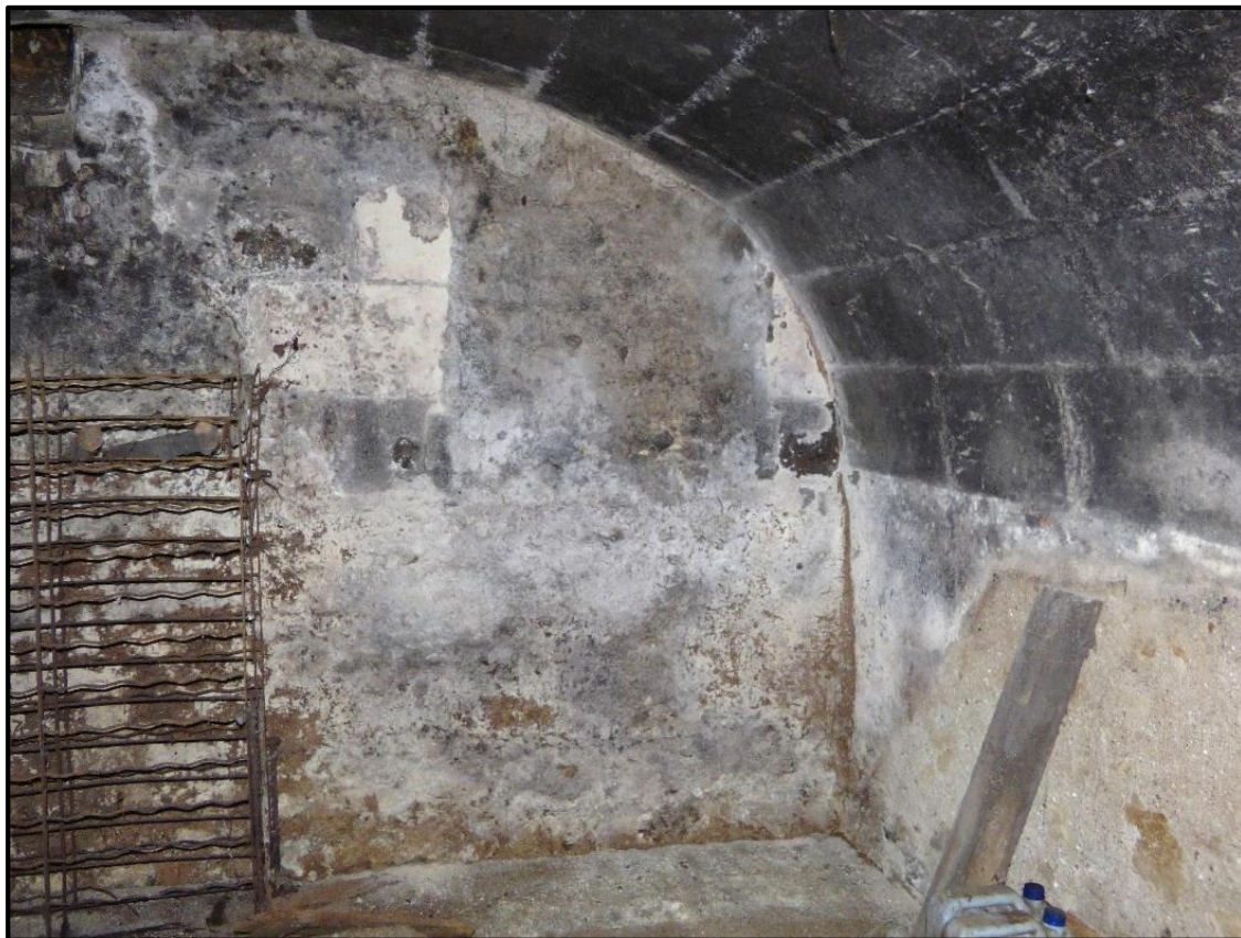
Figure 186. Cave récemment installée (XIX e ou XX e ) s'appuyant sur le mur de refend, et occupant une partie inférieure de la construction du XII e .
