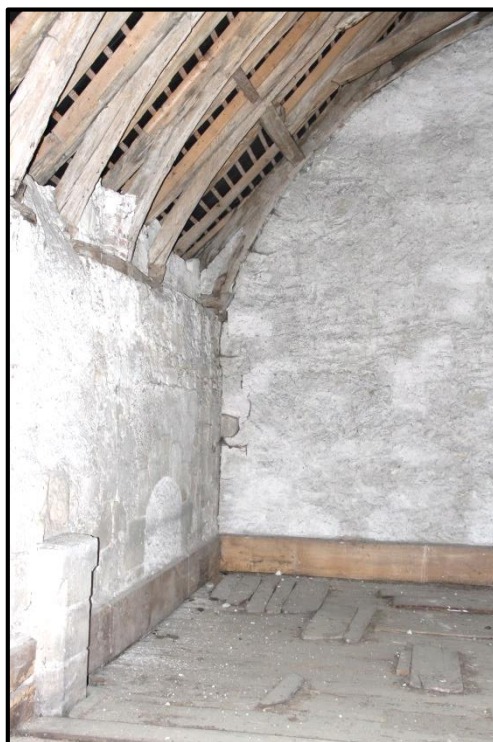
Figure 172. Bien que le plancher initial ait été déplacé, on voit, sur la gauche, le sommet de la demi-colonne en saillie qui supportait une chaîne de poutres longeant le mur, et croisées perpendiculairement des poutres supportant le plancher.
