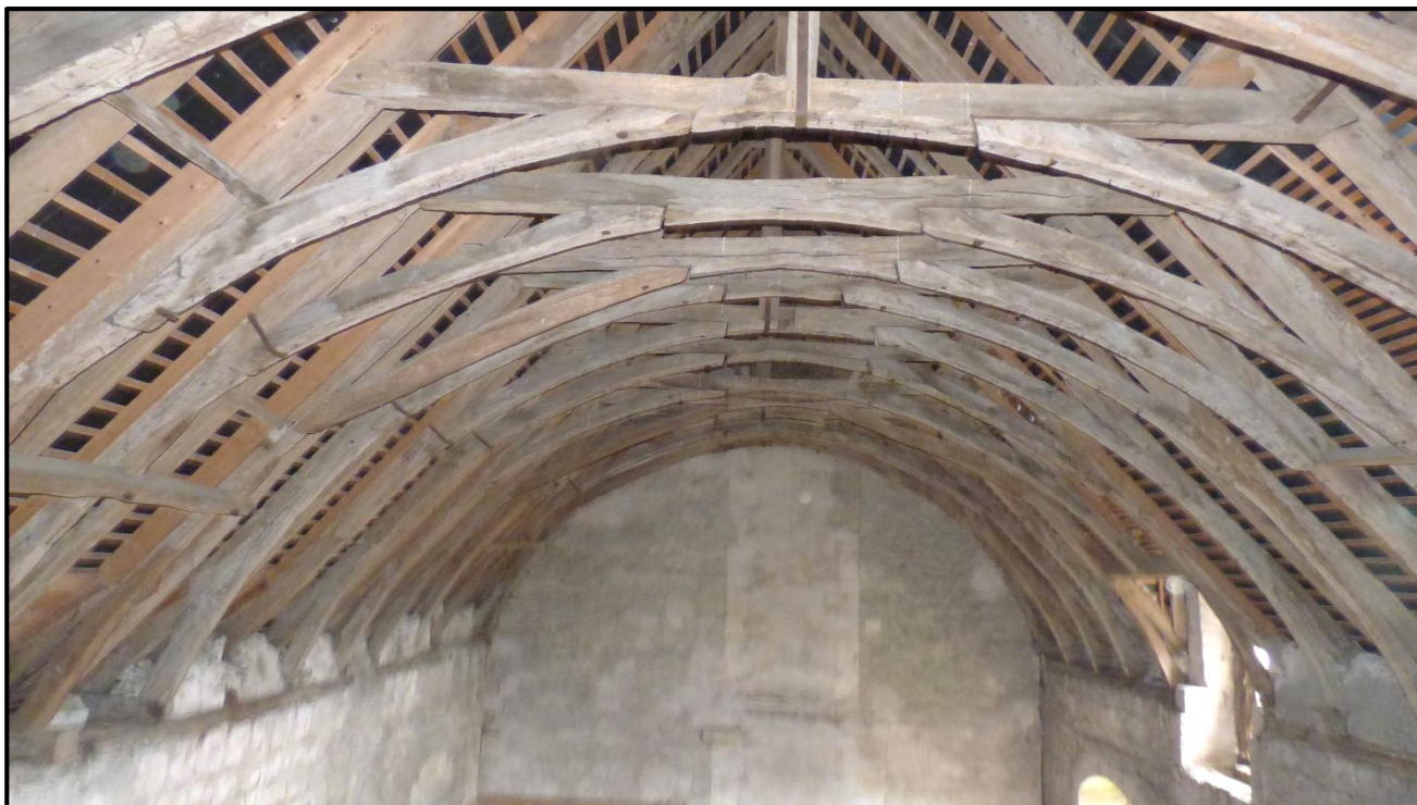
Figure 183. Superbe charpente : les travaux d'entretien (XX e siècle) sont parfaitement identifiables ; on a, entre autres, ajouté des chevrons de sapin entre les fermes de chêne.
