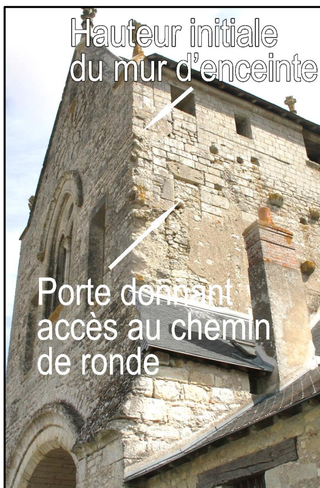
Figure 61. Côté Est du portail . Même vestiges que côté Ouest indiquant la hauteur initiale de la muraille et la présence d'une porte accédant au chemin de ronde, par contre noter que de ce côté la muraille est alignée avec l'angle du portail alors qu'à l'Ouest cette muraille est en retrait.
