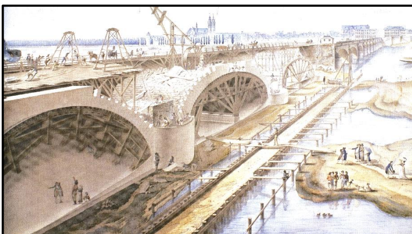
Figure 237. Construction du pont de pierre ; source : archives municipales de Tours
