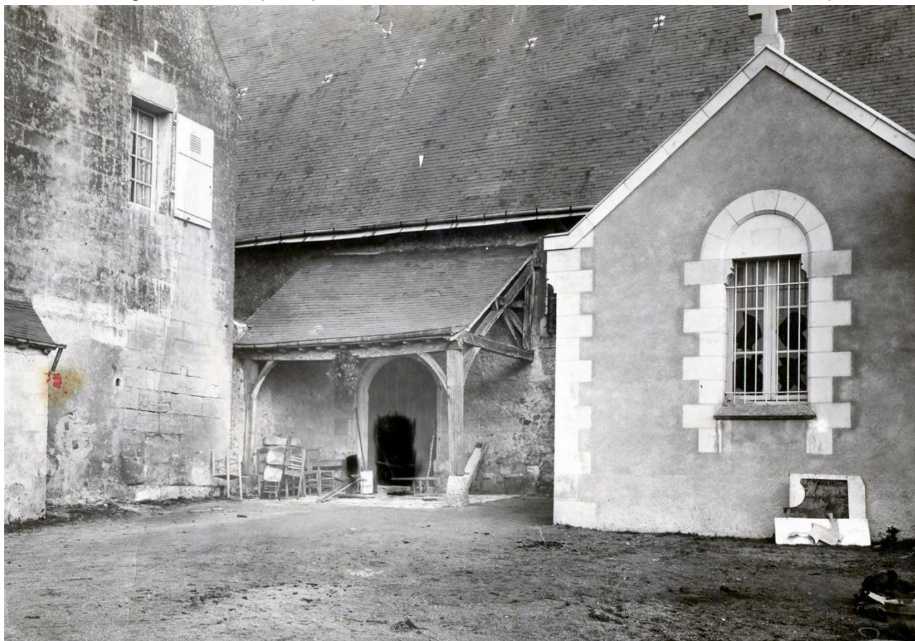
Figure 134. L'entrée de l'église avec sa sacristie ; des traces de violence sont clairement visibles sur la fenêtre de la sacristie et la porte de l'église.
