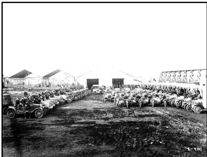
Figure 304. Les véhicules destinés au transport des matériaux et personnes (Photo archives US)
