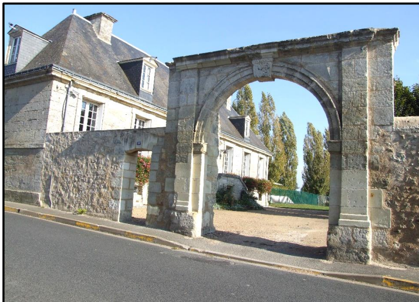
Figure 151. Le porche d'entrée et la façade SUD
