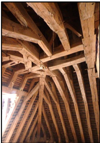
Figure 152. La charpente en carène de navire inversée.
