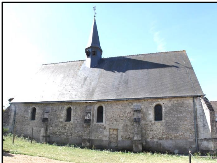
Figure 115 La façade Nord de l'église fut reconstruite et modifiée au XVe siècle.
