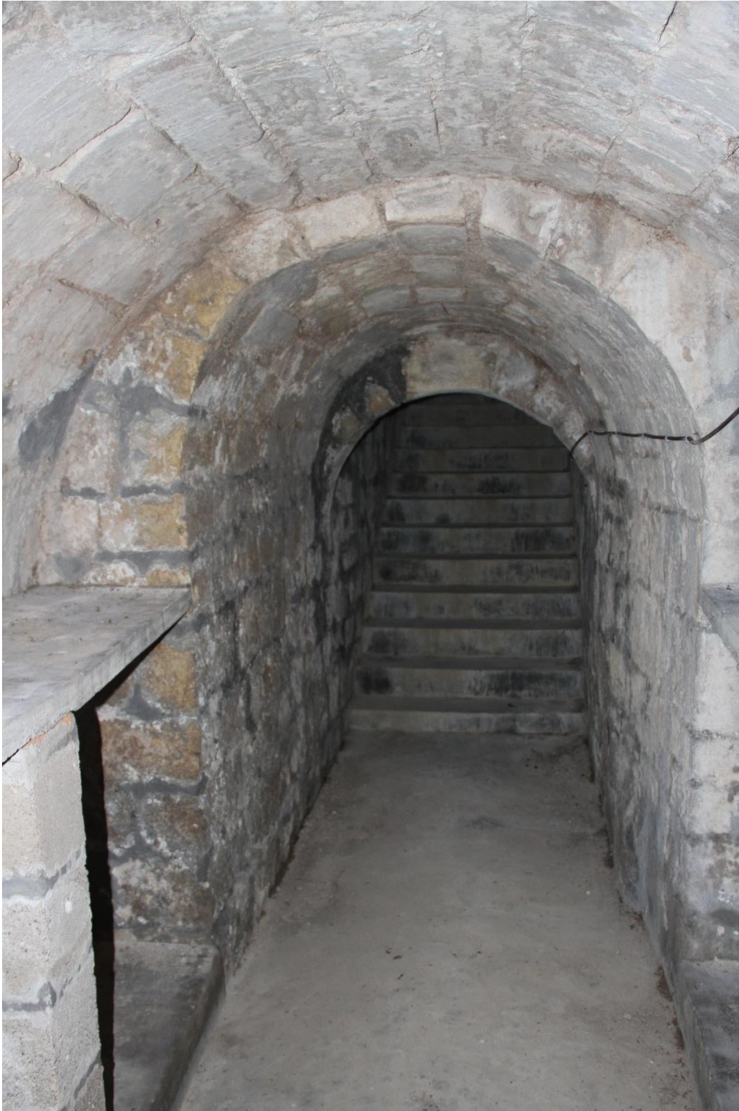
Figure 227 le niveau bas du souterrain, au pied de l'escalier. L'espace disponible fut récupéré pour y installer des casiers à bouteilles ; mais cette utilisation n'est qu'une récupération et ne correspond pas à la motivation des bâtisseurs. On voit bien que ce tunnel est d'abord un lieu de passage
