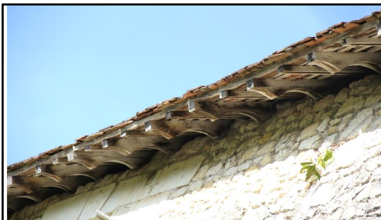
Figure 185. Avant-toit de Crissay-sur-Manse. On retrouve le même profil qu'à Parçay, sauf que la couverture, ici, est de tuiles et non d'ardoises.
