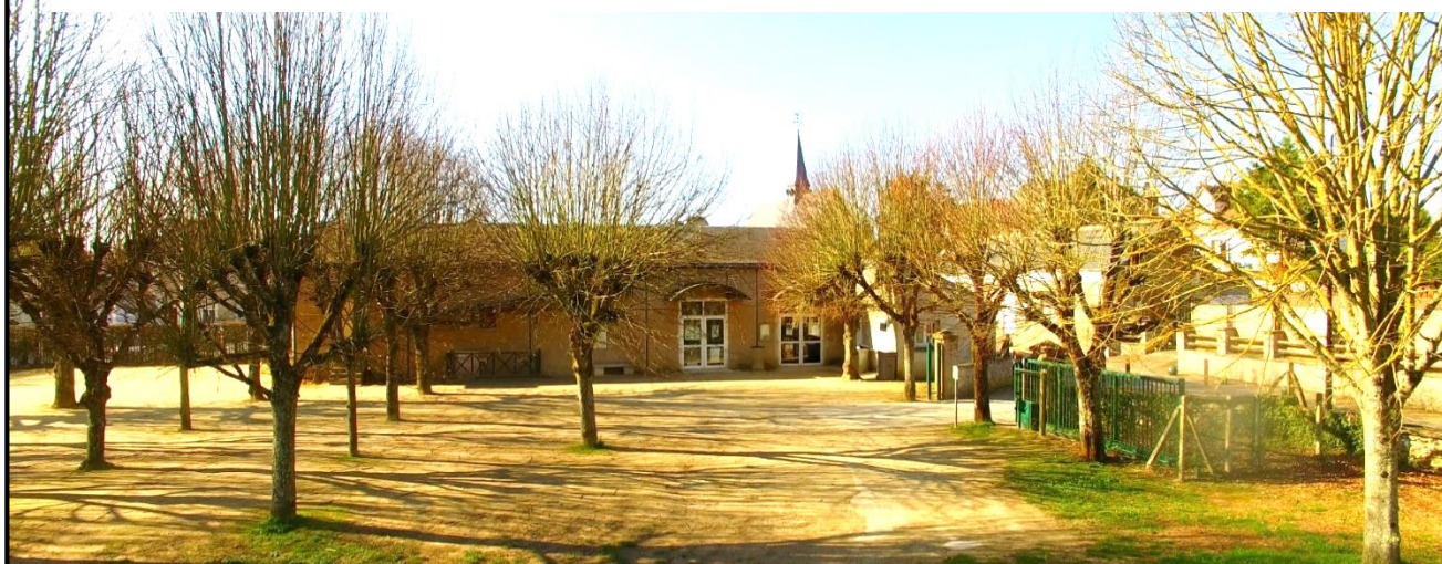
Figure 160. La Salle Saint-Pierre durant l'hiver 2016-2017, avant restauration
