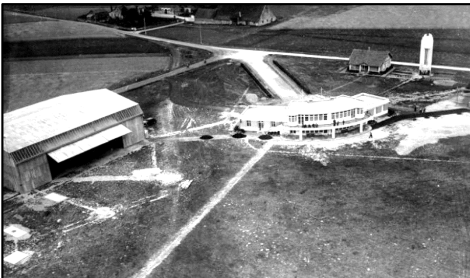
Figure 243. Sur cette photographie on voit la seconde aérogare (en blanc) ainsi que le hangar. La première aérogare est encore en place (chalet) ; sur l'arrière la ferme de la Pécaudière. L'occupation allemande entrainera la destruction de ces bâtiments placés sur la commune de Parçay-Meslay (Photographie ; collection Jean François Barcat)
