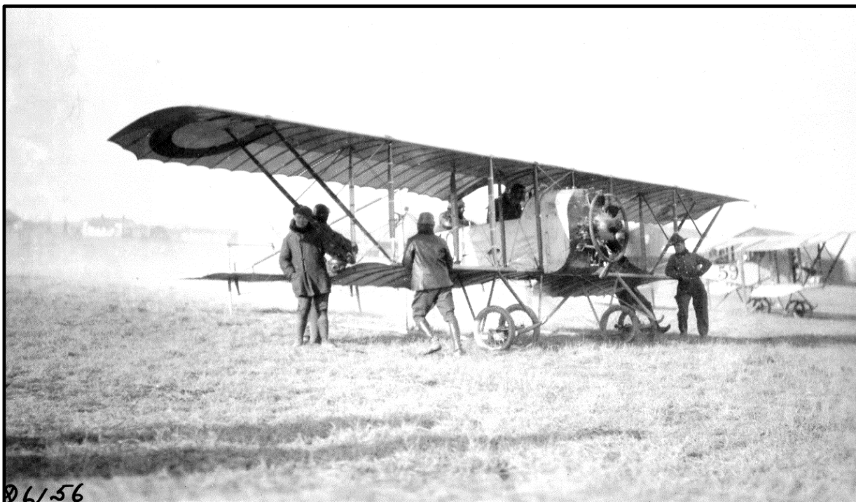
Figure 331 Le Gaudron G3 semble être le premier appareil qui fut utilisé sur le camp de Parçay ; c'est en tout cas l'appareil sur lequel les pilotes Américains commencèrent à voler. Certains disposaient d'un moteur rotatif. Un moteur rotatif est un moteur à combustion interne tournant autour de son vilebrequin qui reste fixe. Ce type de moteur était très courant au début de l'aviation. Il n'avait pas de carburateur, donc fonctionnait à régime constant ; lors de l'atterrissage, on coupait l'alimentation du moteur pour ralentir. Les difficultés concernaient le contrôle de l'avion ce qui rendait le pilotage délicat ; les forces gyroscopiques faisaient plonger l'avion lorsqu'on tournait d'un côté ou le faisaient se cabrer lorsque tournait de l'autre côté. Noter qu'il y a deux personnes à bord, le pilote et l'observateur. Pas de roue à l'arrière, seulement deux patins.
