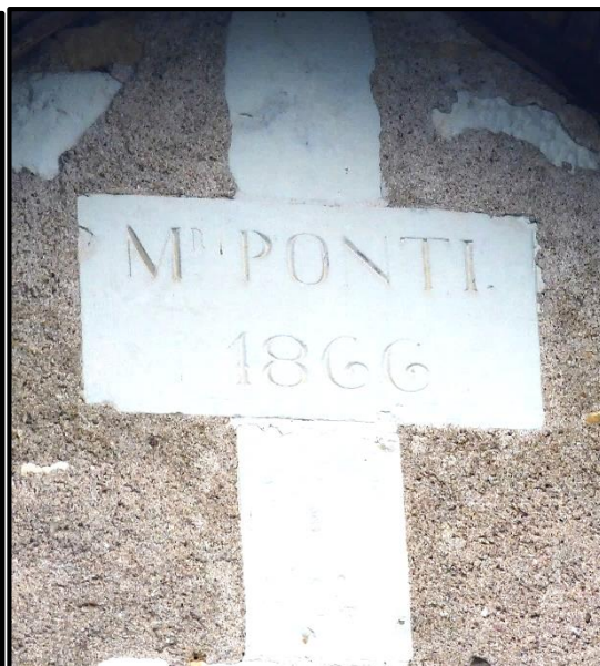
Figure 380. La grange située au Nord du logis seigneurial garde la signature de M. Ponti.
