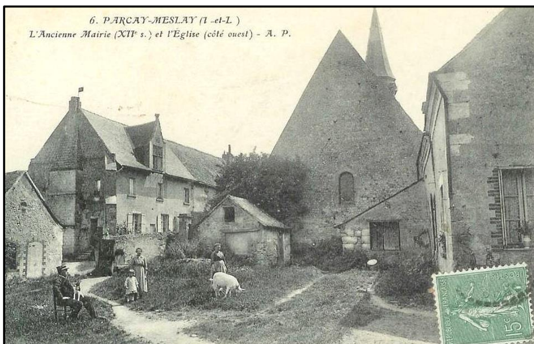
Figure 211. Vers 1900, l'Ouest du logis seigneurial avait encore l'allure d'une ferme, comme un siècle plus tôt. Cette photo est très intéressante on y voit à gauche l'écurie, en face du logis seigneurial, devant l'église les constructions bâties par René Rousseau c'est-à-dire le hangar appuyé contre le mur de la maison ainsi que la boulangerie. On distingue le puits sur la gauche.
