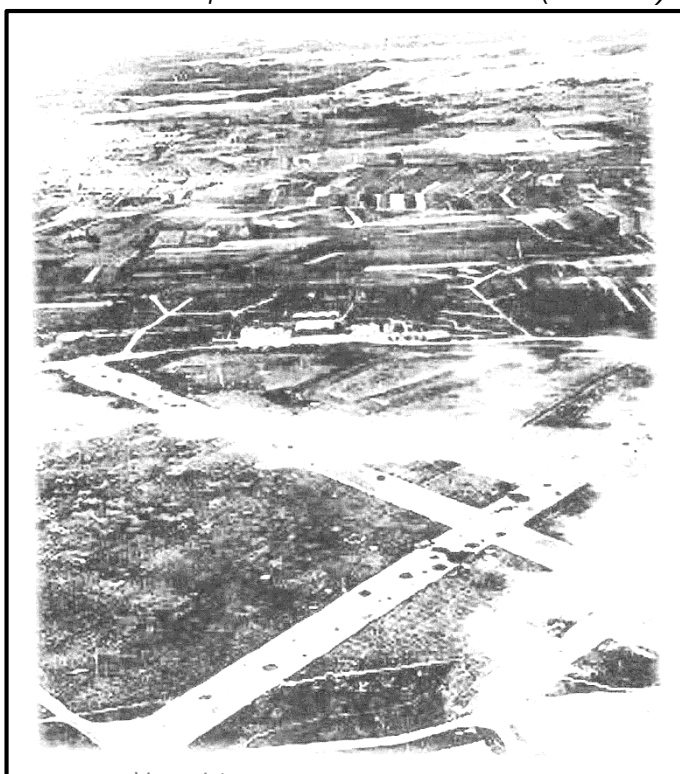
Figure 367. 1944 les pistes de Parçay-Meslay construites par les allemands, perforées de trous de bombes alliées.
