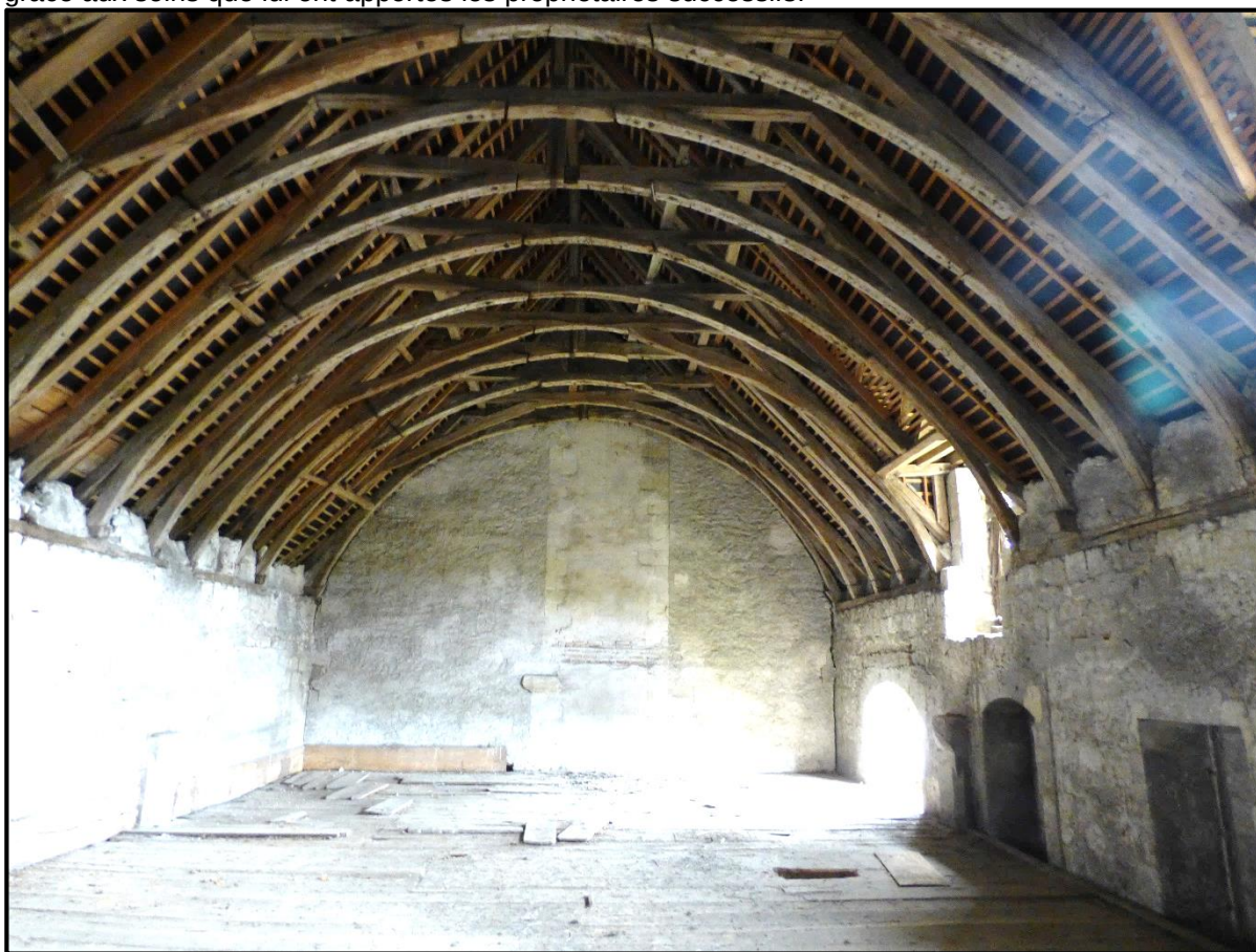
Figure 170. La charpente du logis seigneurial, dans son état de 2015. Noter la présence de clous au bas des poutres, présence démontrant que l'ensemble était autrefois lambrissé.
