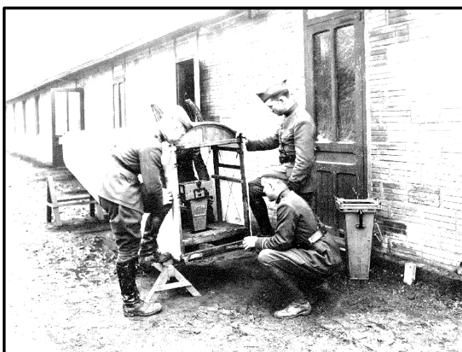
Figure 329. Tentative de fixation de l'appareil photo sur la carlingue de l'avion (Source Archives US)
