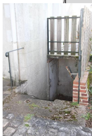
Figure 224. Entrée du souterrain
