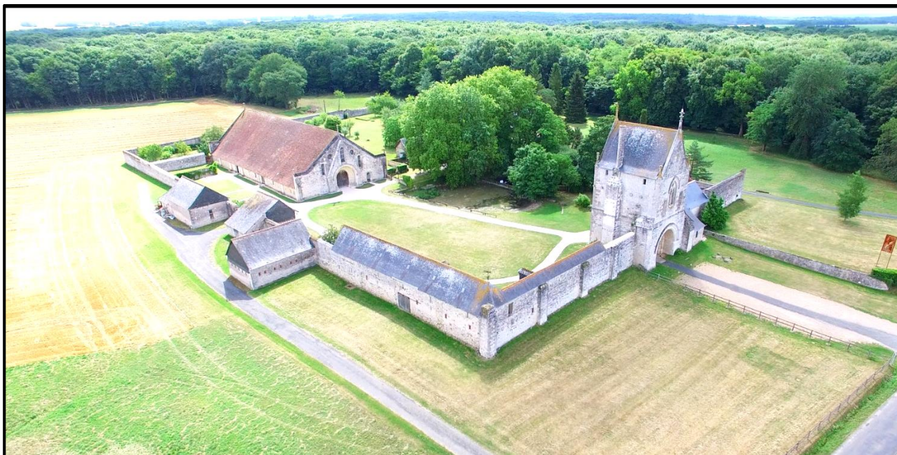
Figure 57. Sur cette photo aérienne on distingue parfaitement le tracé du mur d'enceinte
