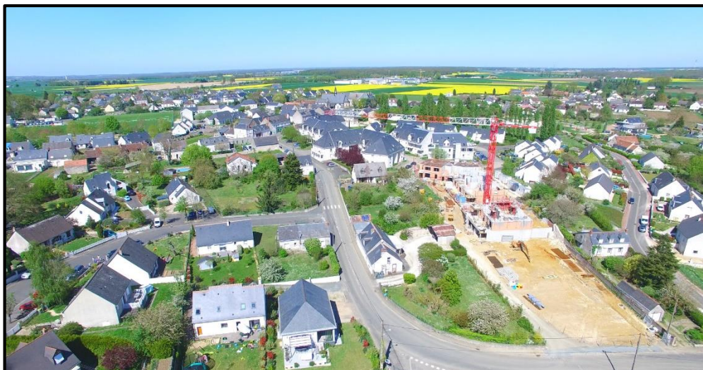
Figure 257. 2017 Extension des immeubles du centre-ville : début des travaux
