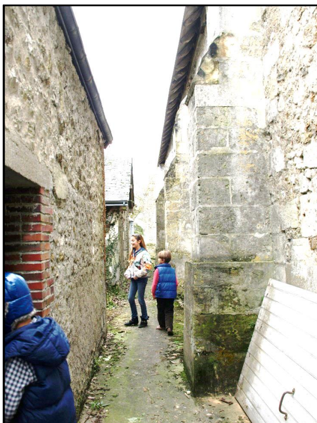
Figure 218. Seul un étroit passage subsistait entre l'église et les constructions
