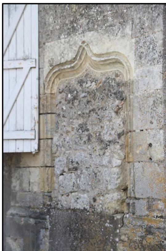
Figure 196. La porter d'entrée de cet escalier à vis existe toujours ; elle fut murée pour l'isoler de la cour de l'école : sa facture est un témoignage du XV e siècle.
