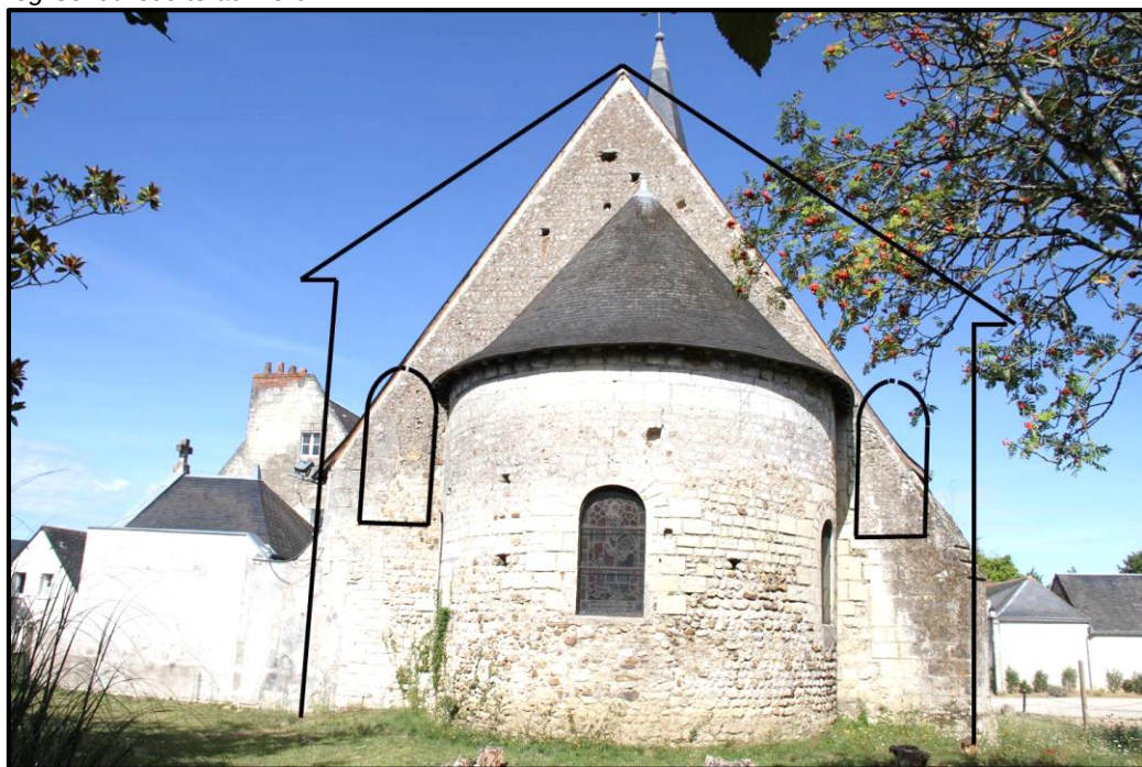
Figure 110 La façade Est coté nord, les traces d'une ancienne baie sont visibles, (ici surlignée) démontrant que l'église fut réduite au Nord
