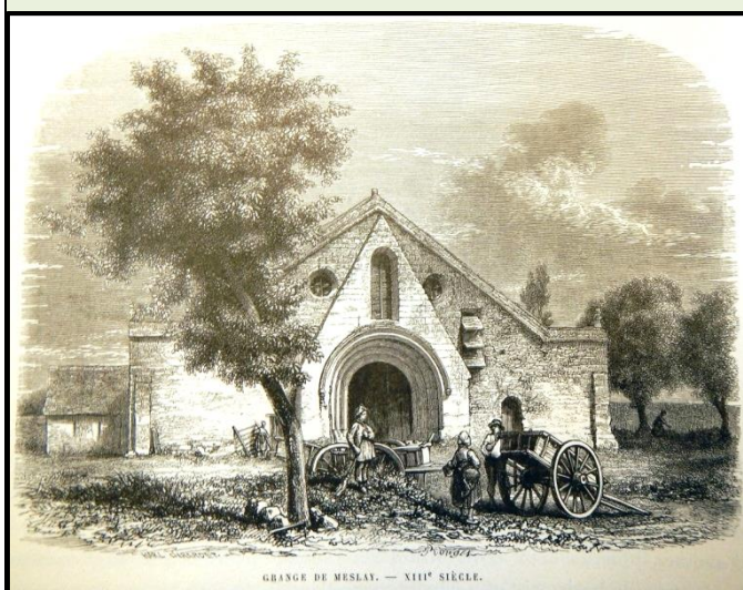
Figure 71 Façade d'entrée de la grange
