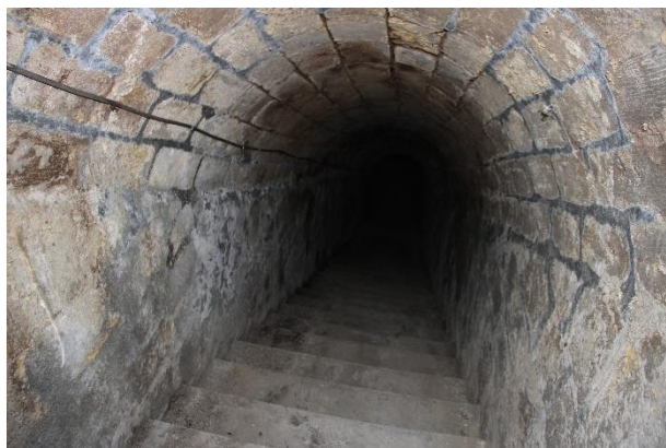
Figure 222. Sommet de l'escalier construit dans l'étape originale
