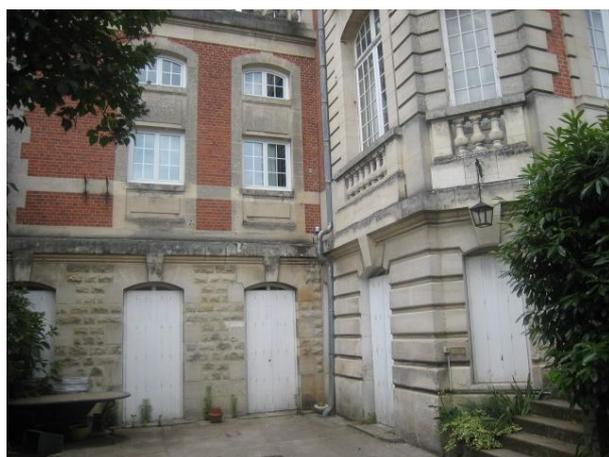
**Figure 20** Sur cette vue d'aujourd'hui on peut constater que la partie gauche, dans sa fraction basse est d'une facture différente du reste de la construction. Les pierres apparentes sont travaillées différemment. Cette portion est un vestige du « château primitif ». D'ailleurs à l'arrière de cette partie on trouve trace de l'amorce d'un ancien souterrain aujourd'hui comblé.
