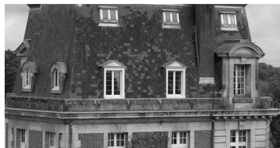
**Figure 175** Face Ouest, on s'aperçoit que les deux ouvertures de gauche ont été élargies, ce qui n'a pu être entrepris sans intervenir sur la toiture, ce qui n'est pas le cas des fenêtres face nord.
