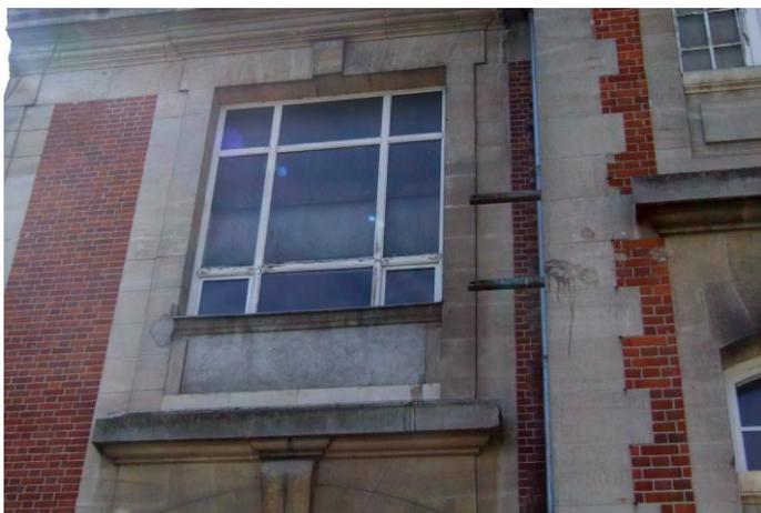
**Figure 173** Fenêtre où les balustres ont été remplacés par du béton
