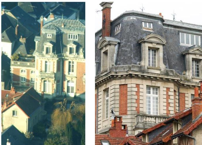
**Figure 75** Construction de briques et pierres blanches, lourdes corniches sculptées, rambardes à balustres, larges et hautes ouvertures sous une toiture à la française revêtue d'ardoises
