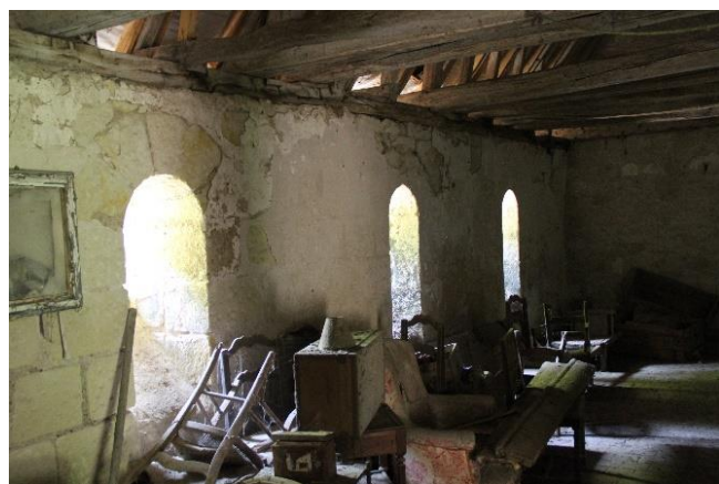
Figure 117. Le niveau supérieur; la charpente d'origine avec ses entrails, sol en carreaux de terre cuite.
