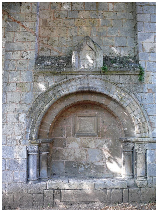
Figure 53. Enfeu Roman, implanté dans l'Eglise saint-Hilaire-le-Grand de Poitiers (photo source Wikimedia). On peut penser qu'une construction de même style se positionnait sous le plein cintre Est du clocher
