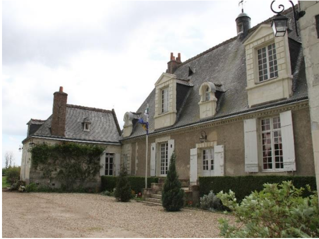
Figure 187 La façade Nord.
