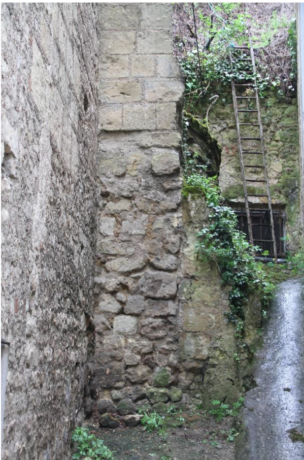
Figure 30. On distingue parfaitement la partie du XIe (mur de gauche en petit appareil) le contrefort du XII en moyen appareil, et en dessous de cette partie du XII un mur semblant plus ancien, au parement irrégulier. Ce pan de mur pouvait constituer le mur Sud du sanctuaire primitif. Ce mur aurait été largement détruit lors de la construction du XIe siècle.
