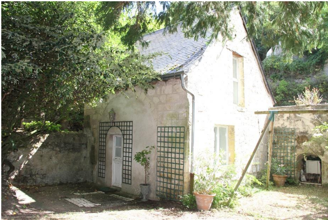
Figure 92. L'ancienne maison du closier. La maisonnette a été fortement remaniée; remarquer l'ouverture cintrée murée côté propriété. Côté rue le mur garde trace de l'ancienne devanture d'une boutique.
