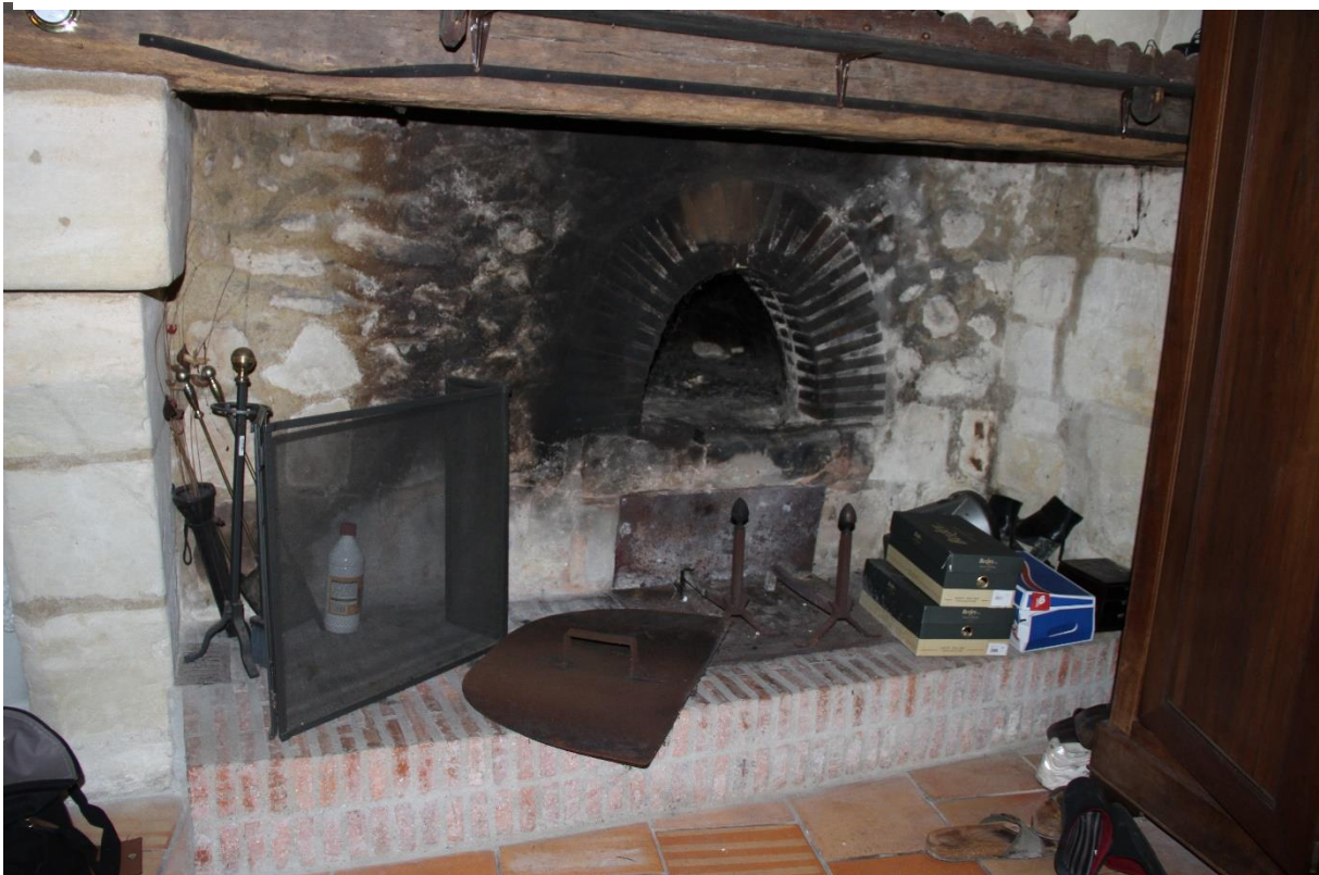
Figure 85. Dans un coin du salon précédent, cheminée avec son four à pain
