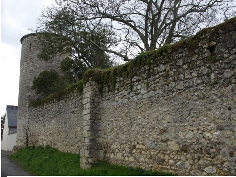
Figure 218. La tour du hibou aujourd'hui. On aperçoit le mur d'enceinte de Marmoutier que la construction de l'autoroute A10 a partiellement détruit
