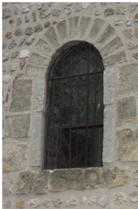
Figure 46. Les angles latéraux de la baie ont été modifiés ultérieurement en y incrustant des pierres de nature différente.
