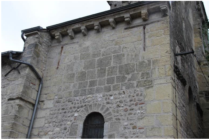
Figure 49 Le passage de « petit appareil », en « moyen appareil » avec les moellons plus importants, renseigne sur les modifications apportées sur le haut du chœur.
