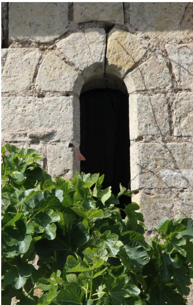
Figure 120. Baie en forme de meurtrière (extérieur)
