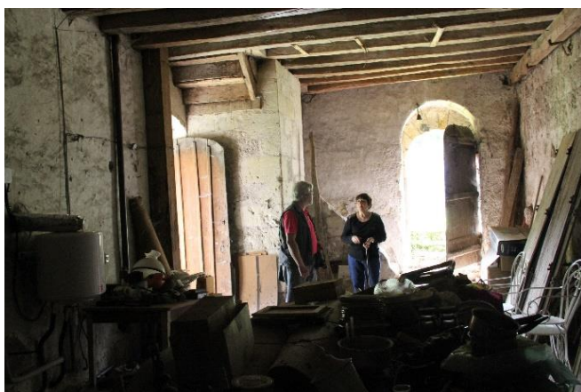
Figure 118. Rez-de-Chaussée de la chapelle avant travaux; la mezzanine faite au XIII e repose sur les poteaux de bois : au fond, à gauche, l'escalier pour accéder au niveau supérieur
