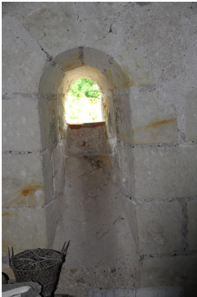
Figure 119. Baie vue de l'intérieur (partiellement obturée)
