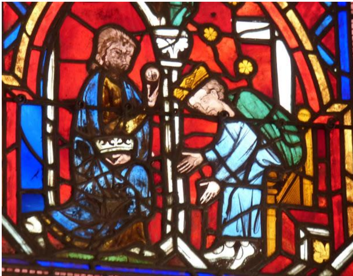
Figure 64 Registre inférieur du vitrail du XIII e siècle. (On voit que les plombs sont saillants vers l'intérieur de la chapelle, alors qu'ils devraient l'être vers l'extérieur, cela démontrant son montage à l'envers)
