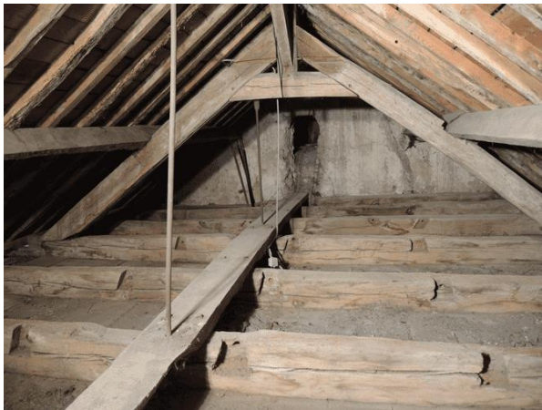
Figure 34. La charpente de la nef de la chapelle Saint-Georges.
