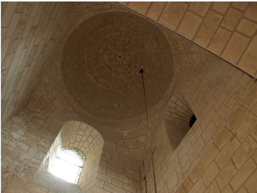
Figure 52. Intérieur du clocher avec sa coupole de pierre. Remarque importante : noter la présence d'une baie non éclairée ; elle donne sous la charpente du chœur, et permet d'accéder dans les sous-pentes. Cela ne justifie pas son existence ; elle est identique à la baie Est. Initialement, cette baie aveugle donnait au Sud, vers l'extérieur, apportant lumière et clarté. Sa présence démontre que le choix de la forme actuelle de la charpente du chœur fut tardif et décidé après l'érection du clocher.
