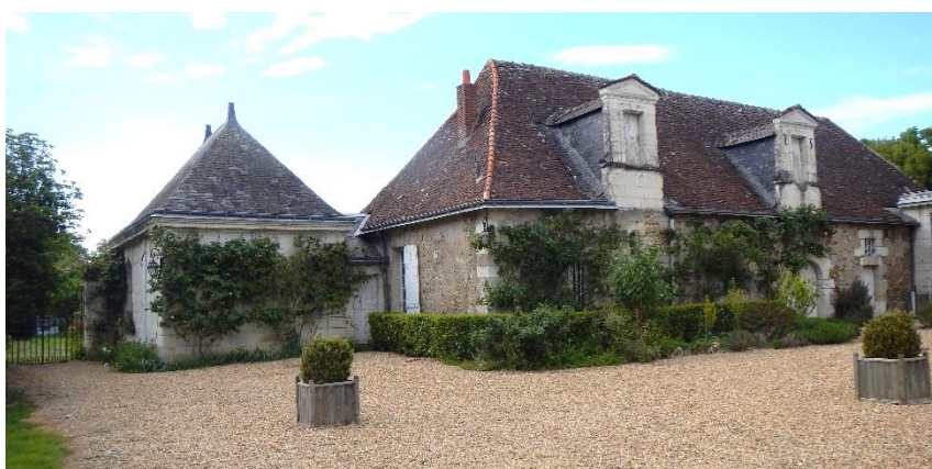
Figure 188 A l'Est et à l'Ouest de la cour, les communs (Ici, côté Ouest) ; on aperçoit sur la droite la porte cintrée donnant accès à l'ancien pressoir.
