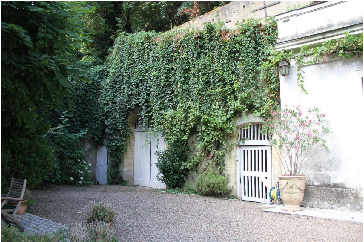
Figure 89. A l'ouest, le long du coteau, les entrées de deux caves
