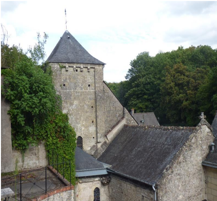
Figure 50 Au Nord Est le clocher; on peut constater la modification de la toiture du chœur, maintenant à un seul pan, et plus haute que celle de la nef, qui n'est pas modifiée.
