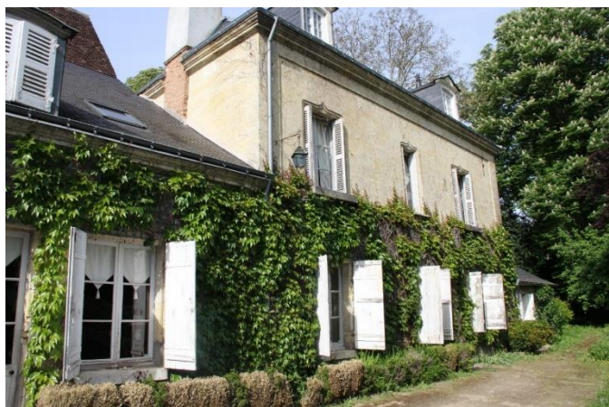
124 La maison accolée à la chapelle en 2015 (avant travaux)
