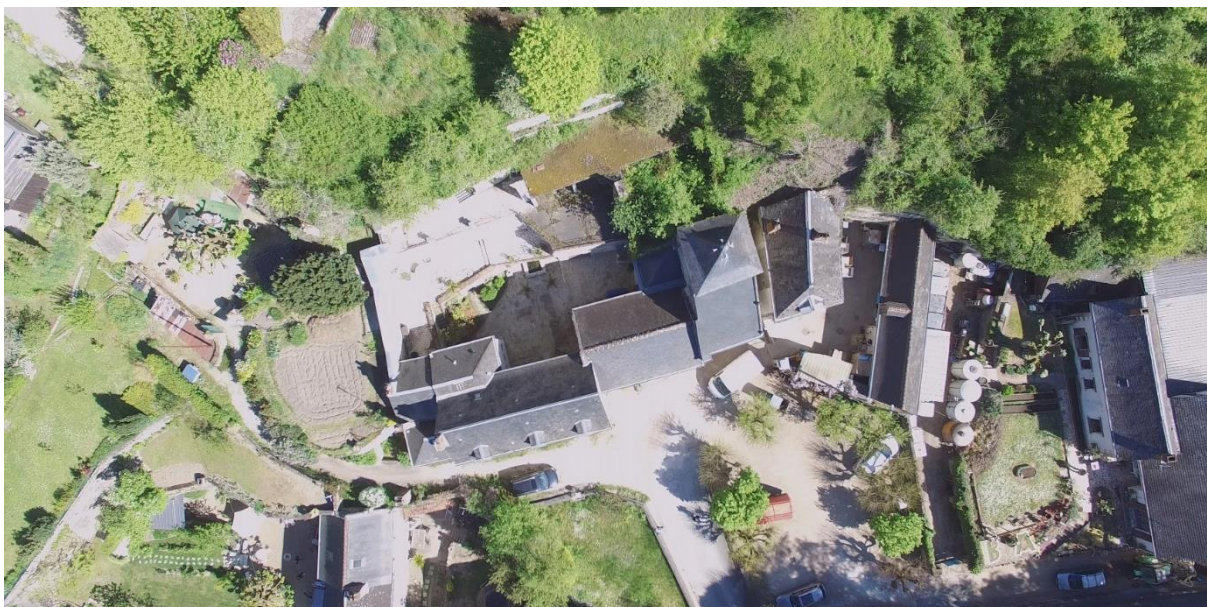
Figure 74. La chapelle et l'ancien presbytère: vue aérienne.
