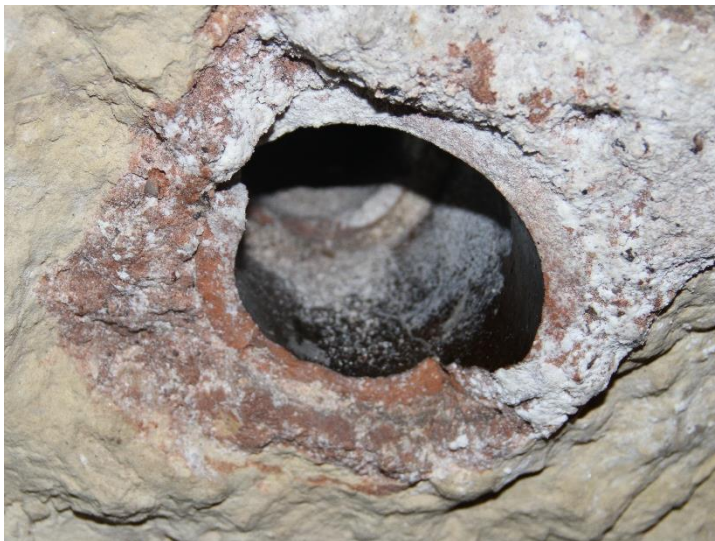
Figure 21. Cette canalisation de terre cuite scellée d'un ciment chargé de brique pilée lui donnant cette couleur rouge est typique de l'époque Gallo-Romaine (source; manoir des Basses-Rivières)
