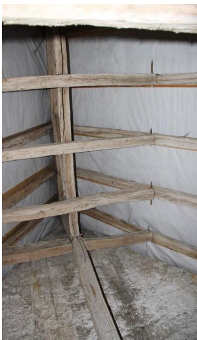
Figure 121. Charpente (2015) avant travaux
